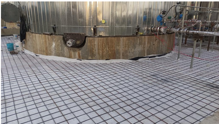
防渗施工现场照片
