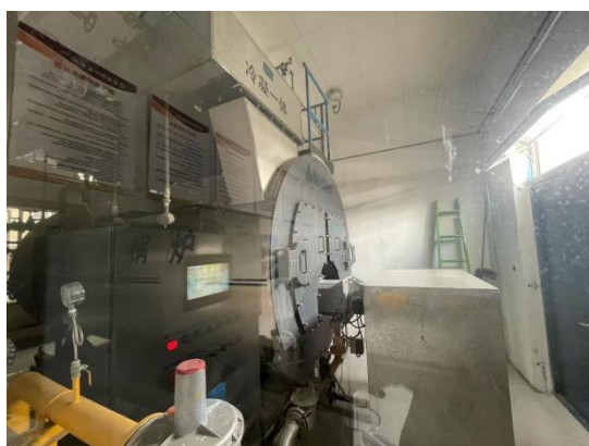
蒸汽锅炉+低氮燃烧器
