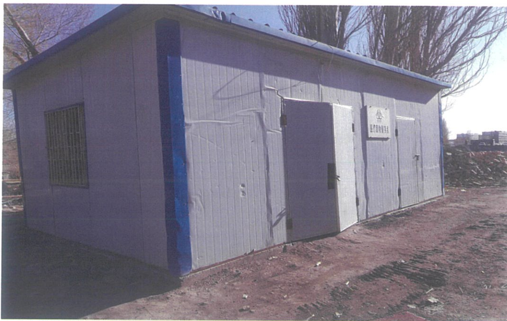
图 1 危险废物暂存房
