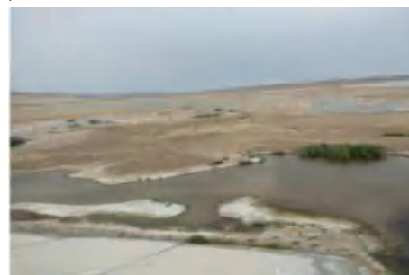
清洁浓盐水防渗储存池
