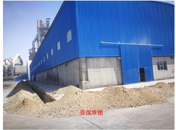
原煤堆棚施工后
