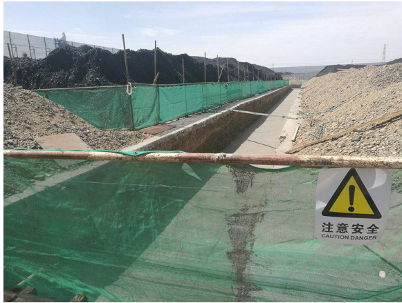
原煤堆棚施工前
