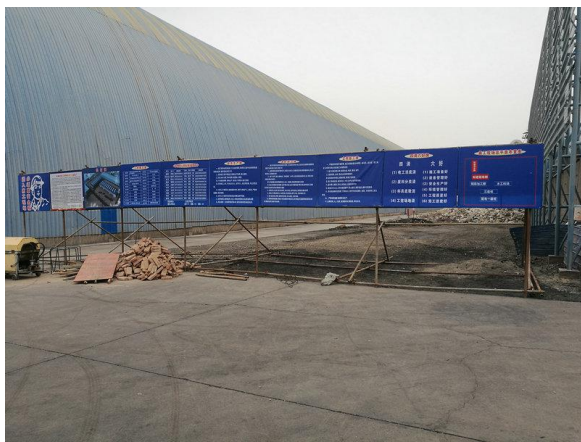
混合材堆棚施工前
