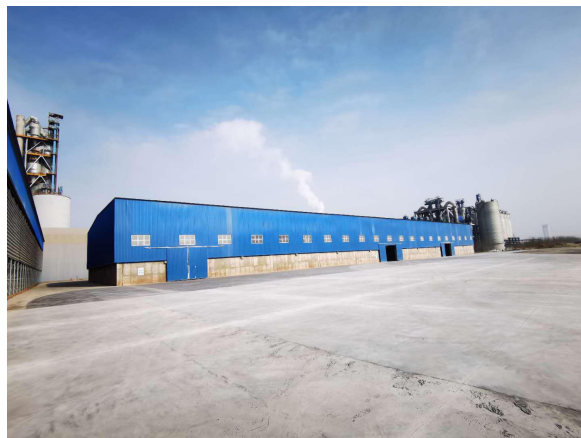
混合材堆棚外部
