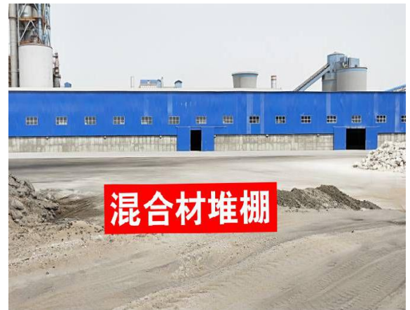
混合材堆棚施工后
